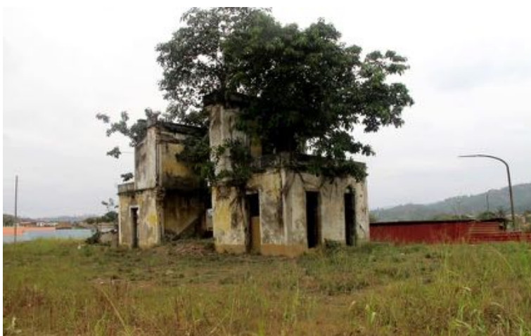
Imagem 12: Estação de Golungo Alto, em ruína.
